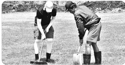
「무너진 축구장 보수공사 중」
